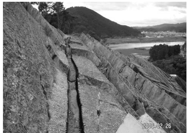
写真-2 トップリング状況(南西方向を望む 沖上氏撮影)
