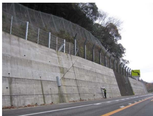
写真-2 ③区間の対策後の状況
