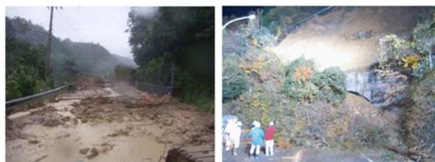
〔対象区間での土石流出〕 〔財田第三トンネル坑口崩壊〕
