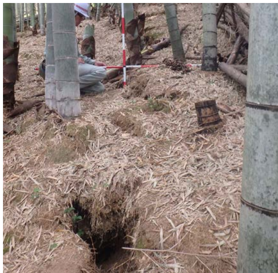
写真 - ④ 主滑落崖の後方に拡大する開口きれつ
