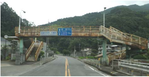
写真-1 川滝横断歩道橋 (令和2年7月時点)
