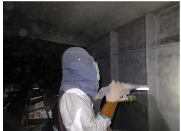
写真-2 ブラスト処理作業状況
