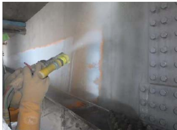
写真4 ダブルブラスト（ウエットブラスト）作業状況
