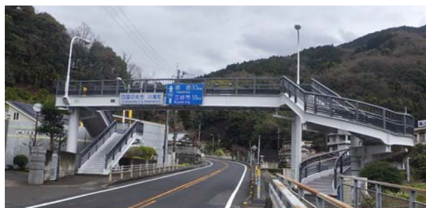
写真-8 塗装塗り替え完成後の川滝横断歩道橋
