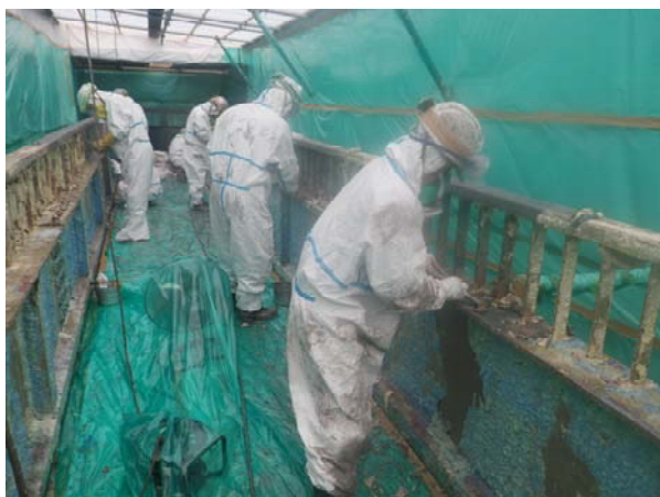
写真3 塗膜剥離剤処理作業状況
