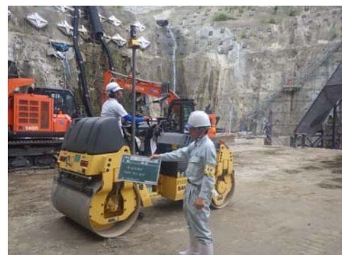
写真-5 4t振動ローラによる転圧状況
