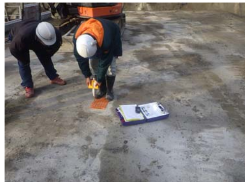
写真-8 降雨後のシュミットハンマーによる強度確認
