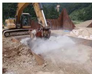
写真-3 バックホウによる攪拌状況
