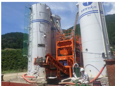
写真-4 メサイアによる攪拌状況
