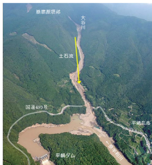
写真-2 平成23年7月 大谷川深層崩壊状況
