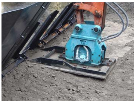
写真-7 FPCによる転圧状況
