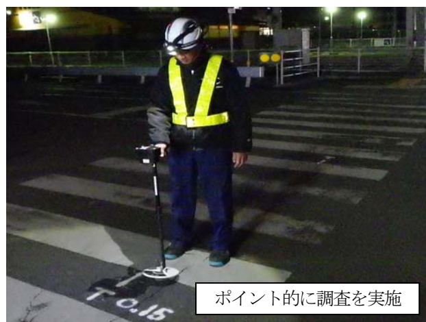
写真-3 非破壊探査実施状況
