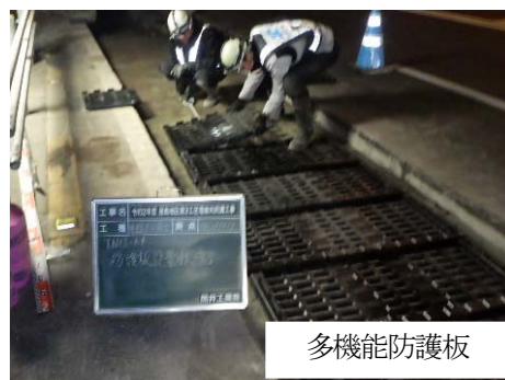
写真-6 多機能防護板敷設状況
