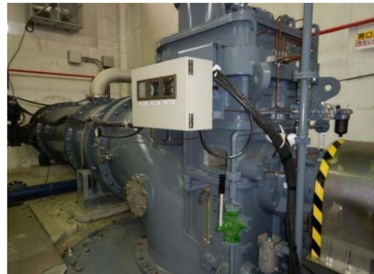
図-9 新設1号立軸斜流ポンプ
