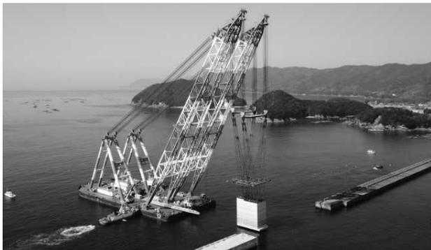
図-9 大型起重機船によるケーソン据え付け状況
