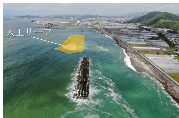
図-2 高知海岸 南国工区 西端周辺
