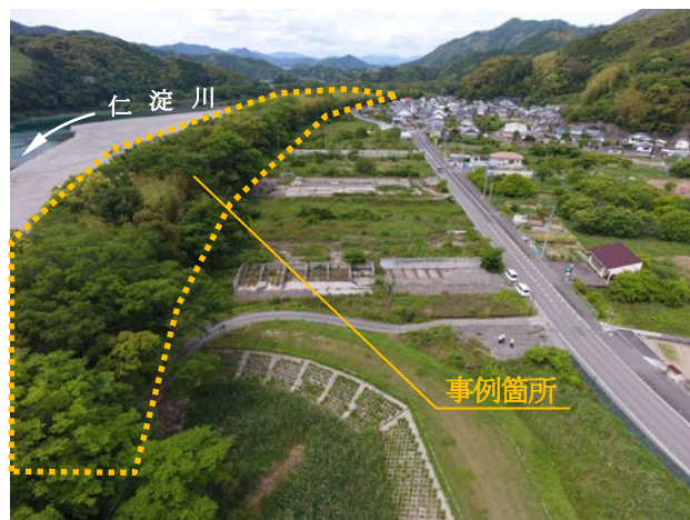
【事例箇所の空撮写真】
