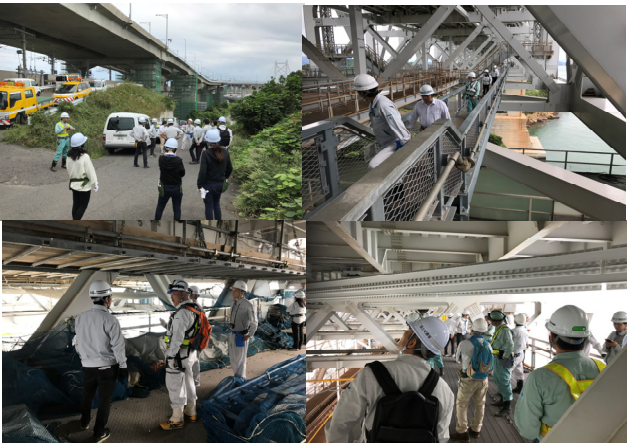
写真-2 瀬戸大橋の耐震補強工事の状況
