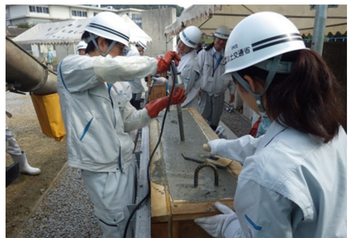
写真-6 コンクリート打設の状況
