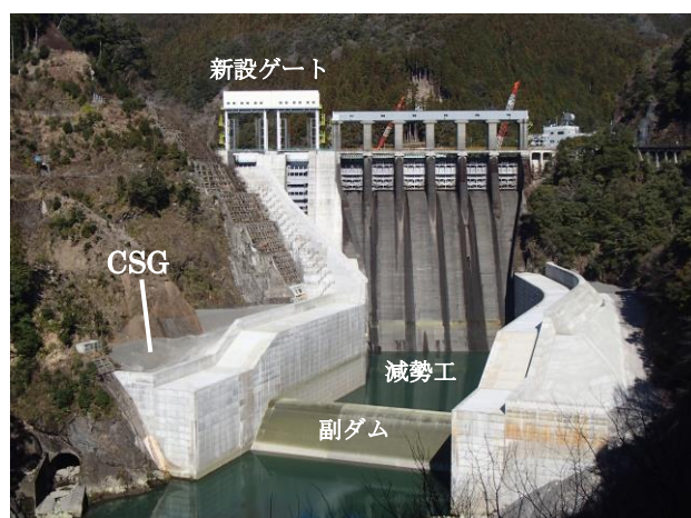
図 2-1 長安ロダム外観図（下流側より）
