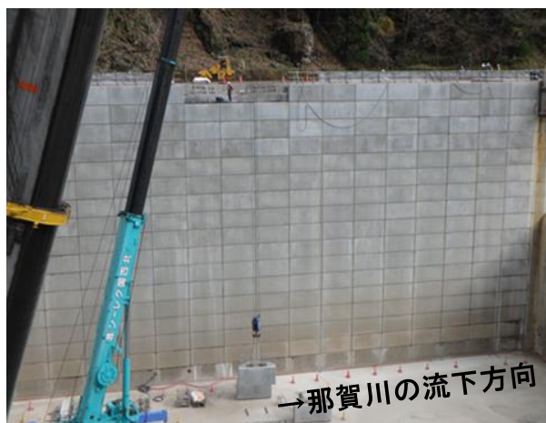
図 3-3 減勢工側壁部表面のプレキャストブロック
