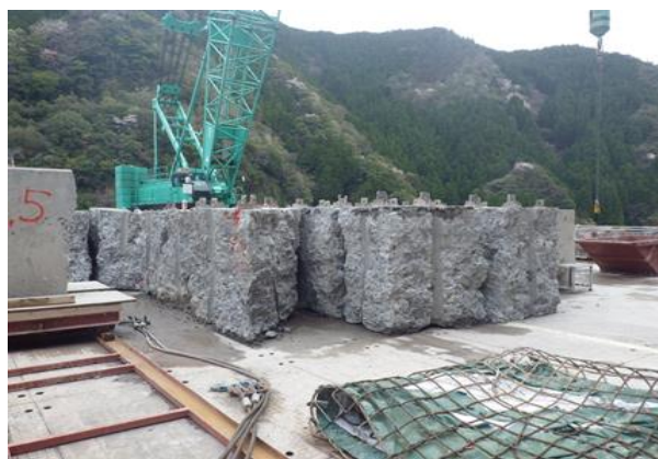
図 3-2 切削された堤体のブロック片
