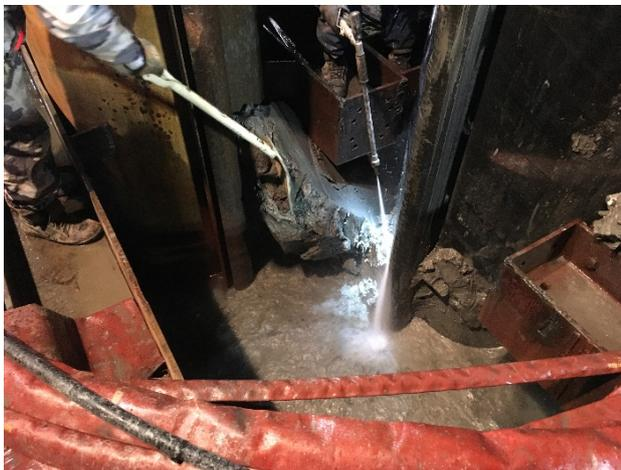
写真-4 固結粘土付着状況
