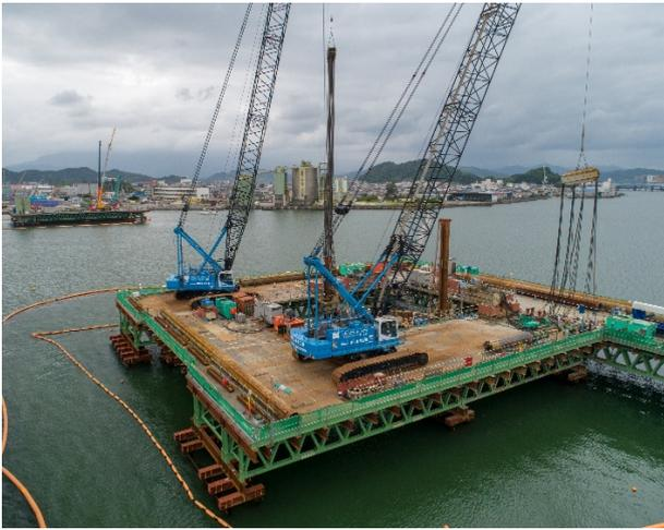
写真-2 鋼管矢板圧入工全景
