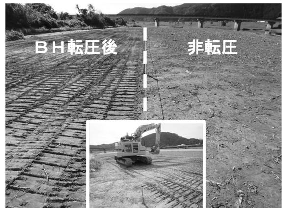
写真4 バックホウ転圧の施工状況
