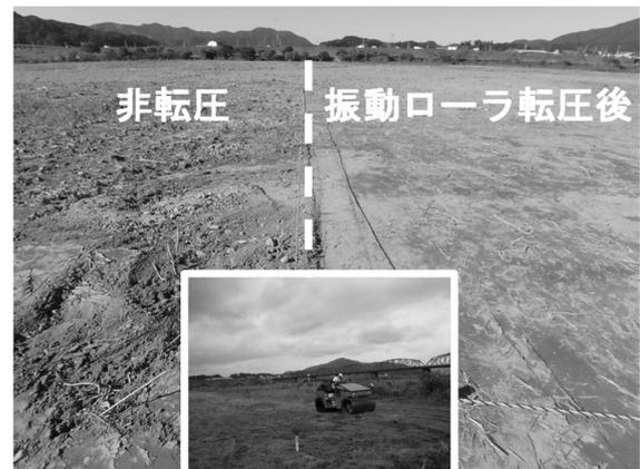
写真5 振動ローラ転圧の施工状況
