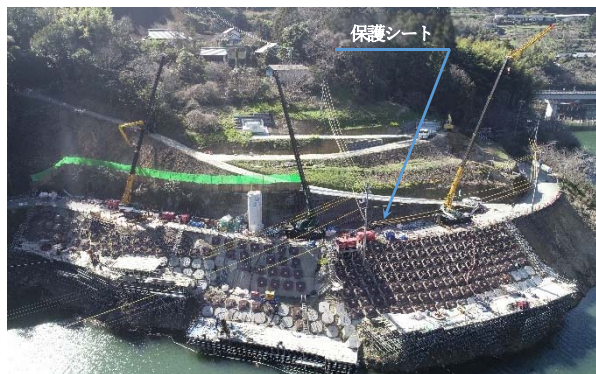
写真-2 現場状況
