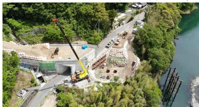
写真-2 A2橋台 (R2.5撮影)
