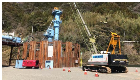
写真-4 艀装設備
