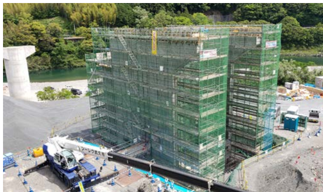
写真-1 A1橋台 (R2.5撮影)
