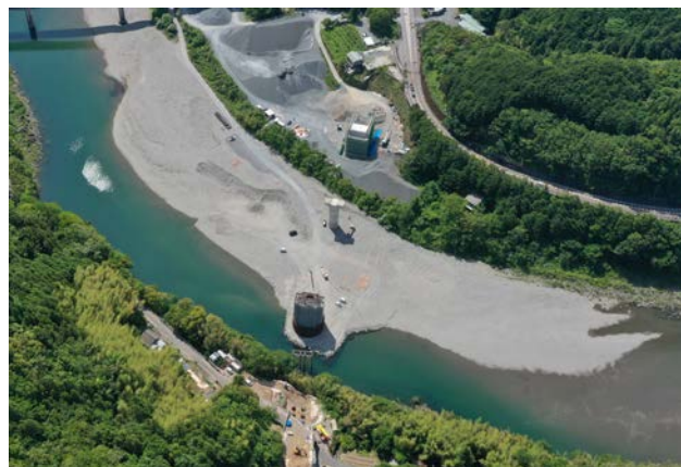
写真-7 各橋台、橋脚の施工状況 (R2.5撮影)
