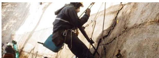
写真-3 アンカーボルト工
