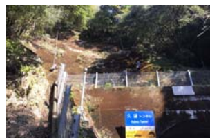
写真-1 施工箇所
