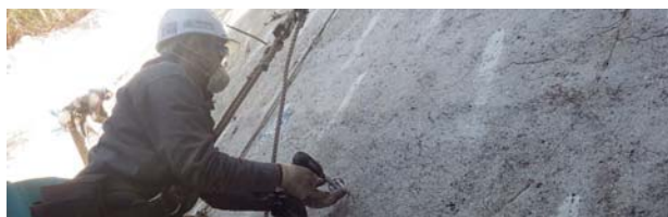
写真-4 カップルボルト工
