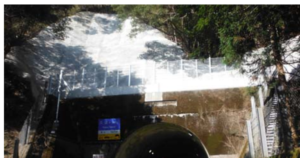
写真-7 完成写真
