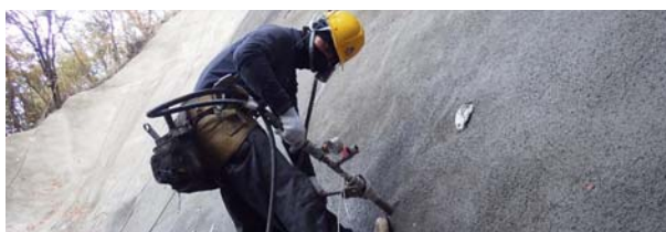
写真-6 空隙充填工
