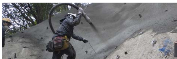
写真-5 増厚工（モルタル吹付け）
