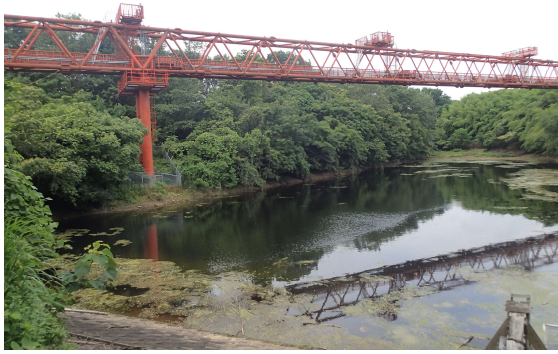
図-12 進入灯橋梁とため池
