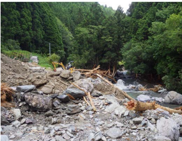
図-4 土砂災害発生直後の被害状況 (2) (保全対象 町道)
