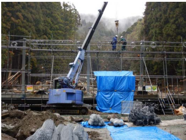
図-6 ワイヤネット施工状況写真
