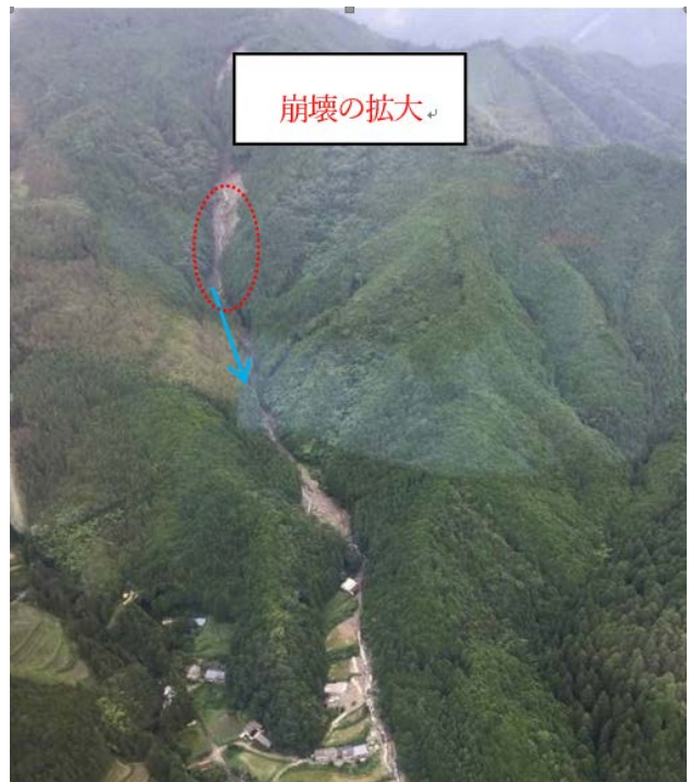
図-9 崩壊位置写真
