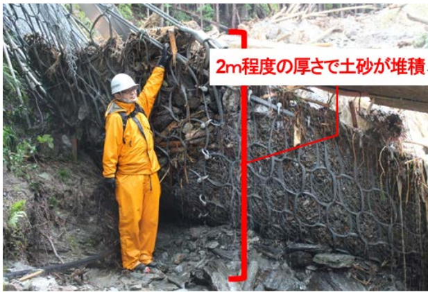
図-11 ワイヤーネット上の堆積土砂
