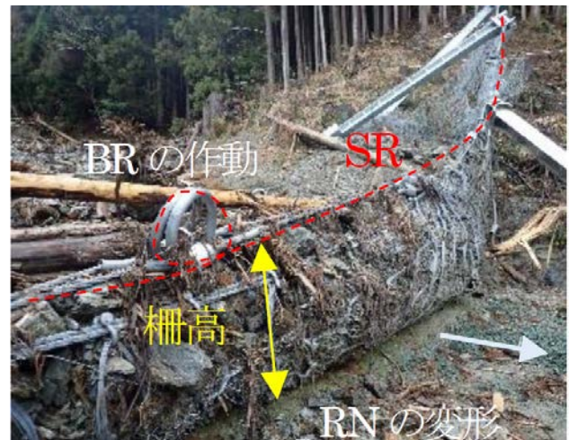
図-14 BR・RN変形状況 (砂防学会投稿論文より引用)
