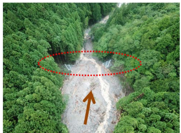
図-10 土石の補足状況
