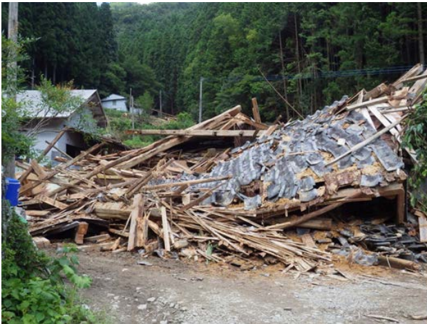
図-3 土石流発生直後の被害状況 (1) (保全対象 人家)
