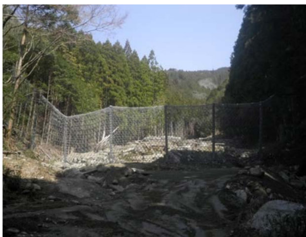
図-7 ワイヤネット設置状況
