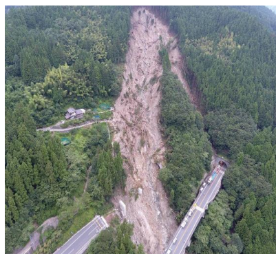
写真-1 大規模な崩壊による高知自動車道の被災状況
