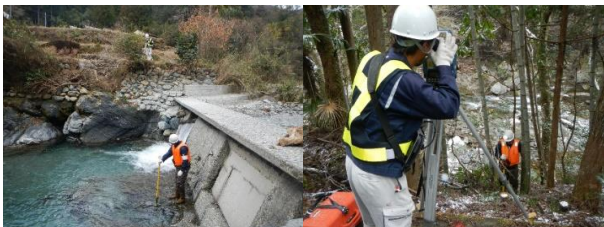
写真-3 河川縦横断測量の様子
