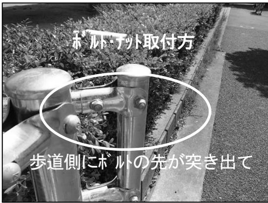
写真-2 施工不良状況
