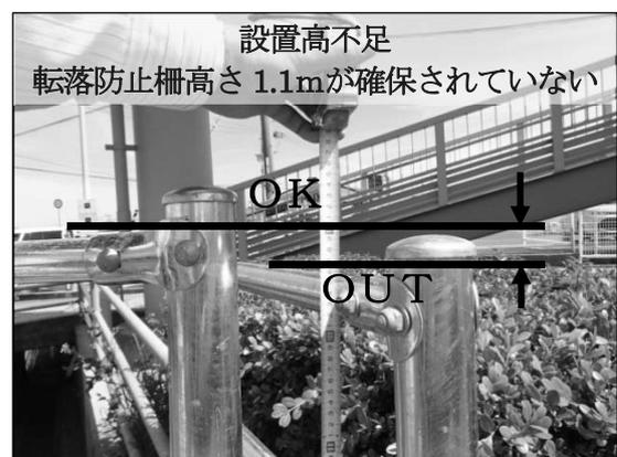
写真-1 施工不良状況
