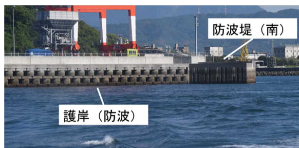
写真-1 防波堤（南）と護岸（防波）
