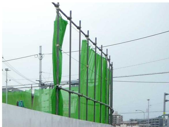
写真-4 飛散防止カーテン
