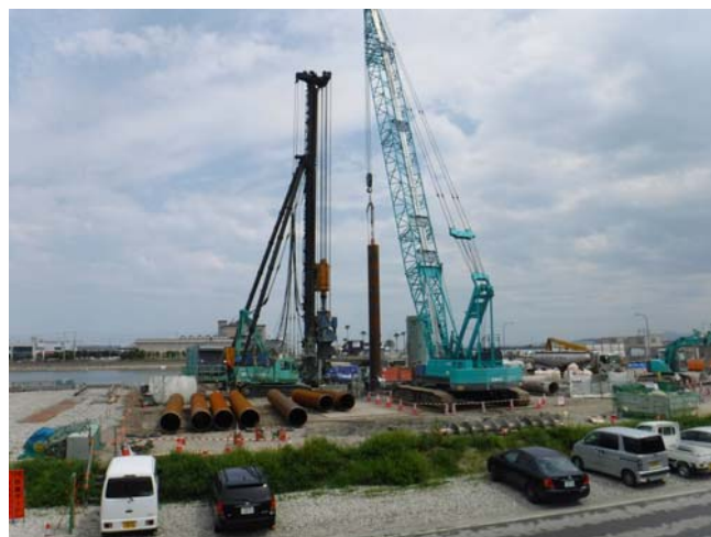
写真-3 鋼管杭施工状況
