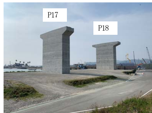
写真-1 工事完成写真
