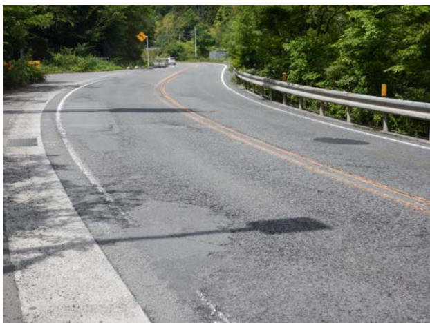
写真-3 国道11号 東温市河之内
