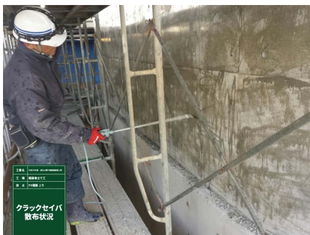
図ー6 乾燥収縮低減剤の散布状況
