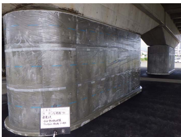
図ー7 保水シートによる養生状況
