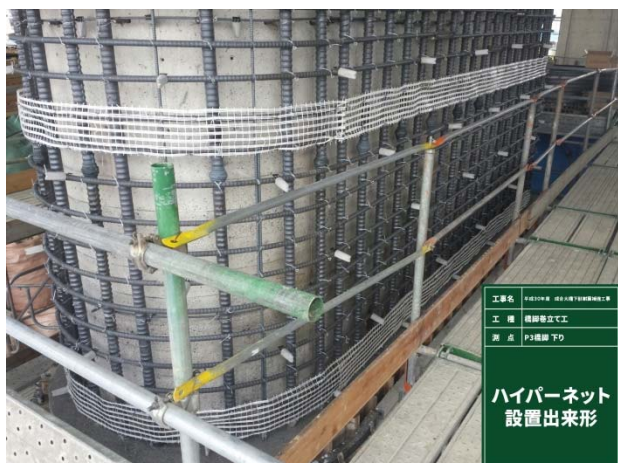
図ー5 ガラス繊維シートの配置状況
