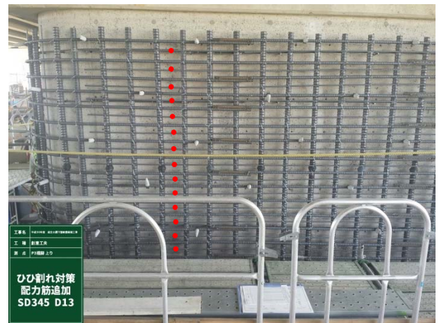
図ー４ ひび割れ抑制鉄筋の配置状況
