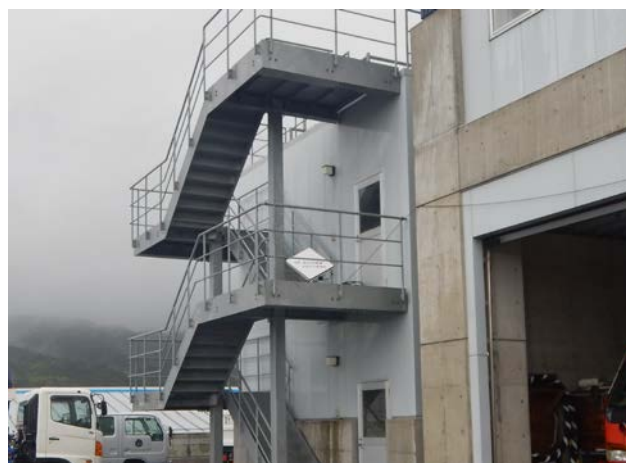
写真-7 Ku-SAT II設置状況
