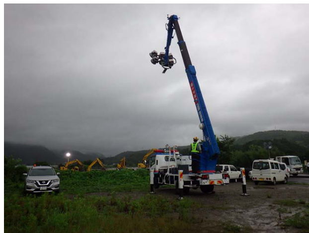
写真-5 照明車による支援
