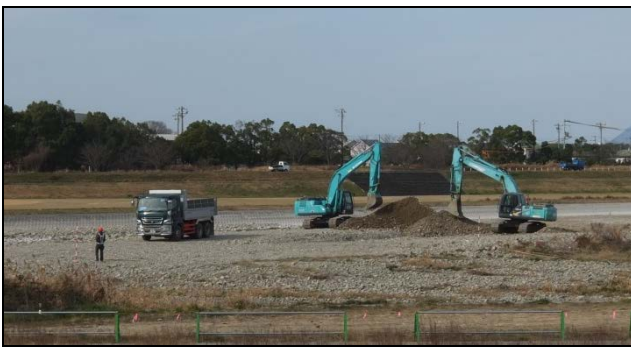
図-4 堆積土砂掘削状況（H31.1.11）
