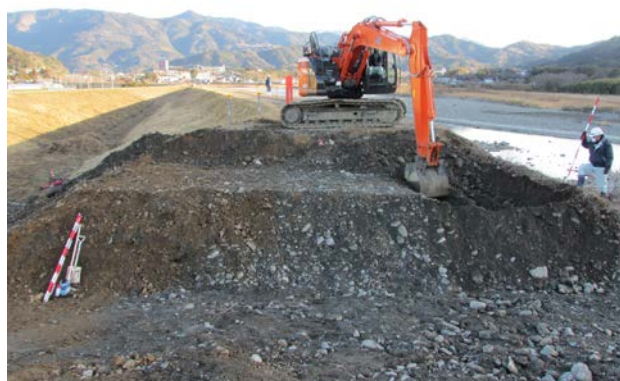
図-10 調査状況の様子
