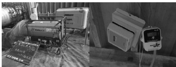
写真-1 サーモスタット付コンクリートファーンレスによる養生温度の管理
