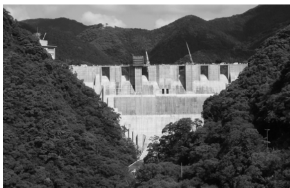
写真-7 現在のダム施工状況（全景）
