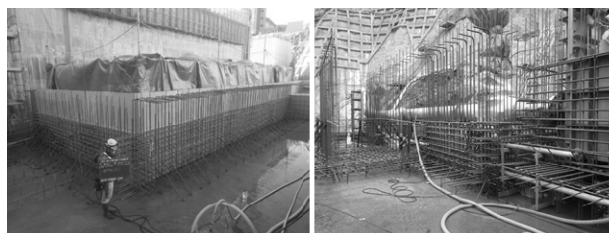
写真-4 大空間部の補強鉄筋設置状況
