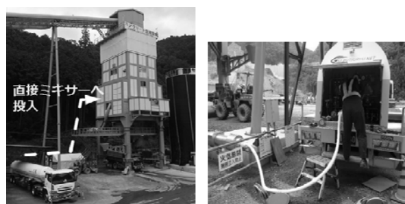
写真-6 液体窒素投入状況
