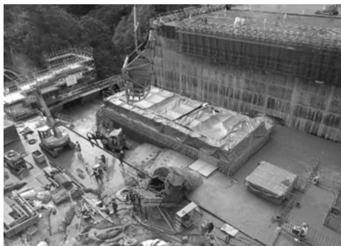
写真-2 大空間部の上部養生写真
