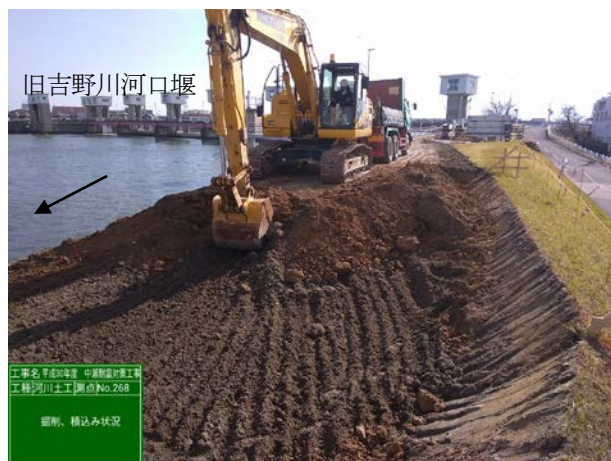
図-5 既設堤防開削状況
