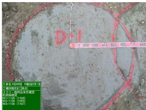
図-7 地盤改良完了
