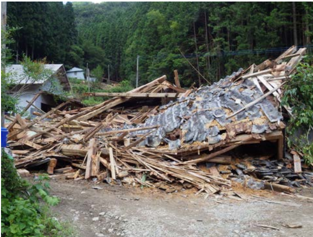
図-5 土石流による人家被災（本山町北山）
