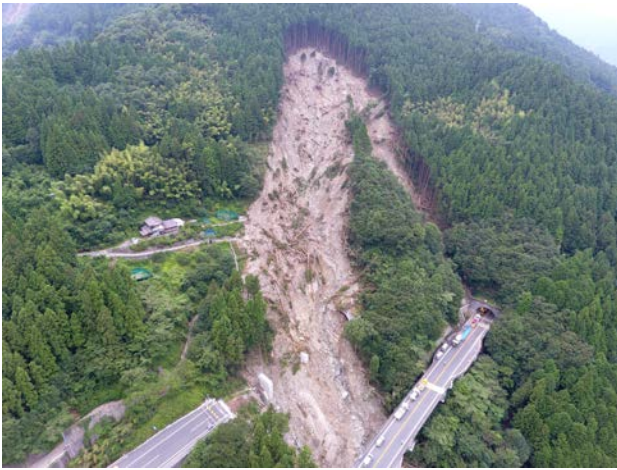
図-3 崩壊による高知県橋梁流出（大豊町立川上名）
