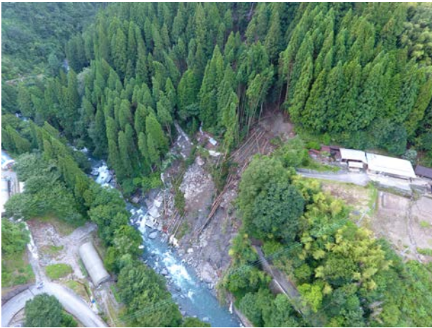
図-4 崩壊による道路寸断（大豊町仁尾ヶ内）
