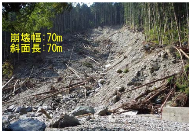
図-8 合流点から 6.5km 地点の崩壊地状況
