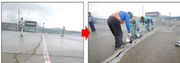
写真-6、写真-7 加熱式充填剤の注入 コンテナヤードの舗装の隙間を埋める緊急工事例②
