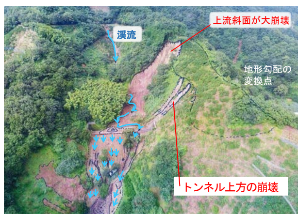
写真-5 法花津地区 (216k500) 崩壊の全景
