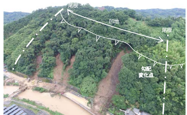
写真-1 立間地区(212k200) 表層崩壊の全景
