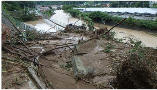
写真-2 崩壊土砂の堆積状況
