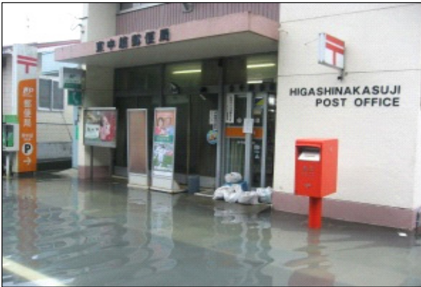
図-3 具同・楠島地区の浸水被害状況
