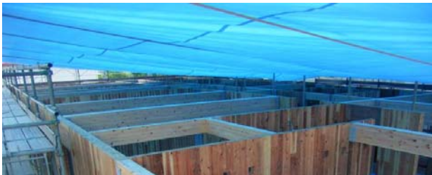
図11 現場での雨対策
