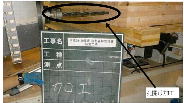
図6 CLTパネル加工状況
