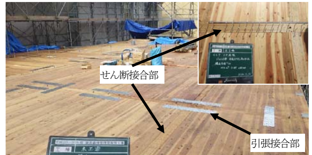
図10 2階床敷設状況
