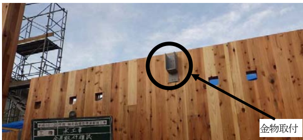
図8 金物取り付け状況
