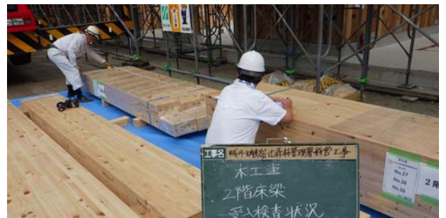
図8 受入検査状況
