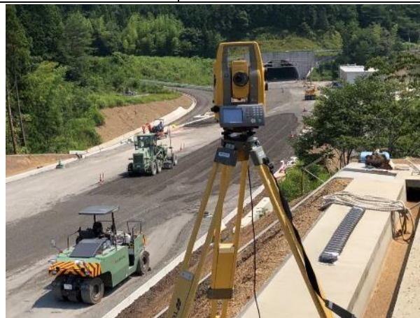
写真-1 3DMC モーターグレーダを用いた路盤施工状況
