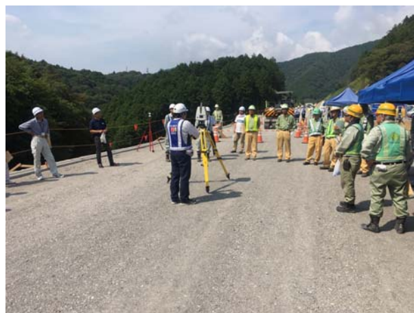
写真-6 ICT 舗装工見学会状況
