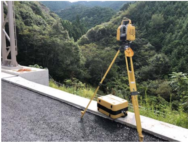
写真-2 TLSを用いた出来形管理状況
