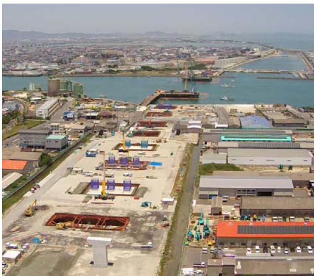
写真-1 工事が進む津田地区
