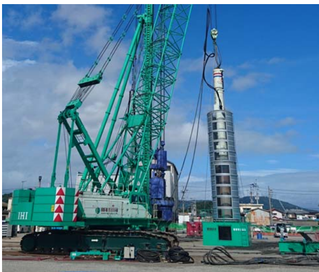
写真-3 油圧ハンマーと筒型防音設備
