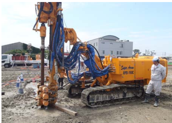
写真-2 補助ボーリング(エンパソル)
