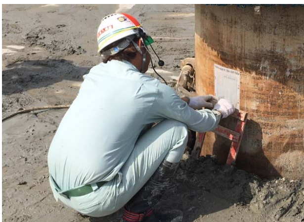
写真-4 支持層到達確認状況
