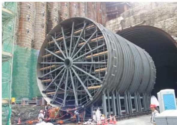
写真-3 水圧鉄管の水平ジャッキによるスライド状況
