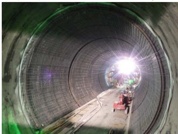
写真-4 トンネル内鉄筋組立状況
