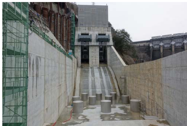
写真-6 減勢工シュート部
