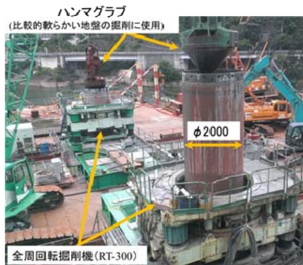
写真-2 岩盤掘削状況
