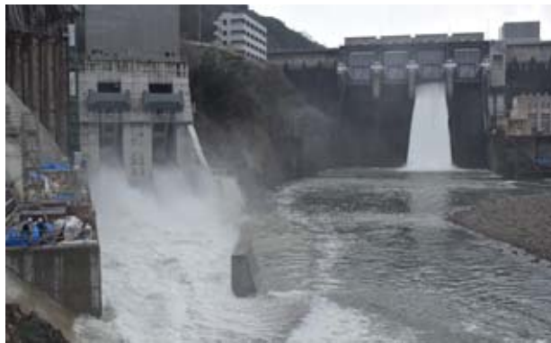
写真-8 トンネル洪水吐放流状況
