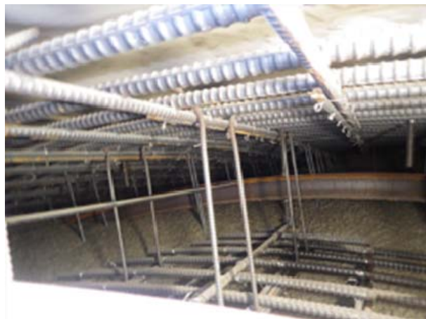
写真-5 覆工コンクリート充填状況
