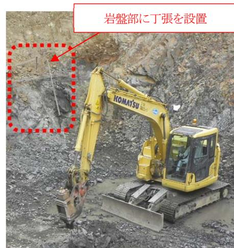
写真-5 岩盤部での丁張の設置
