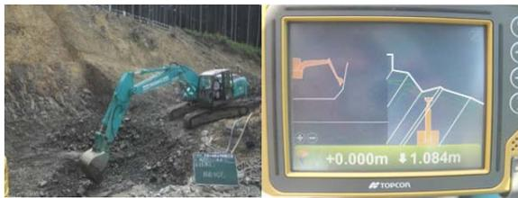
写真-4 掘削状況とモニター画面の例
