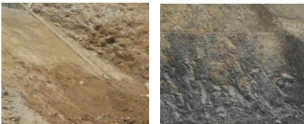
写真-6 土砂(左)と岩(右)の法面の掘削面の状況
