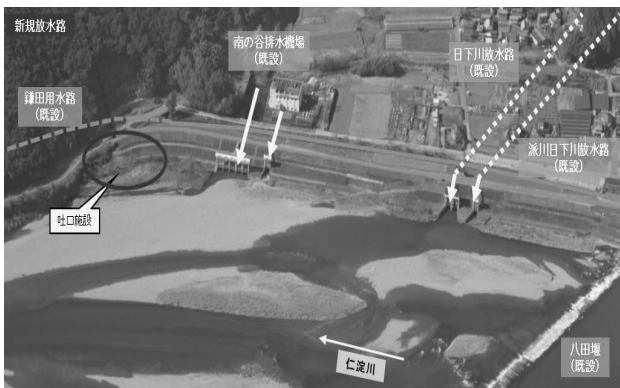
写真-2 新規放水路と鎌田用水路の位置関係
