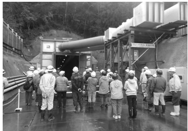
写真-3 新規放水路呑口部における現場見学会の様子
