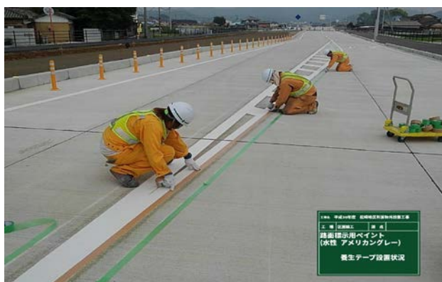
図-4 施工状況 (②マスキングの設置)
