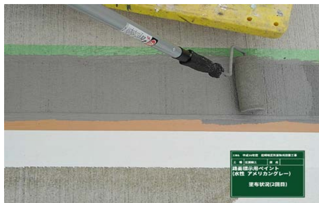
図-6 施工状況 (⑤塗装塗布(2回目))
