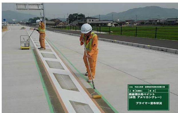
図-5 施工状況 (③プライマー塗布)
