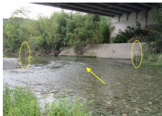
写真-5 ポールの設置状況
