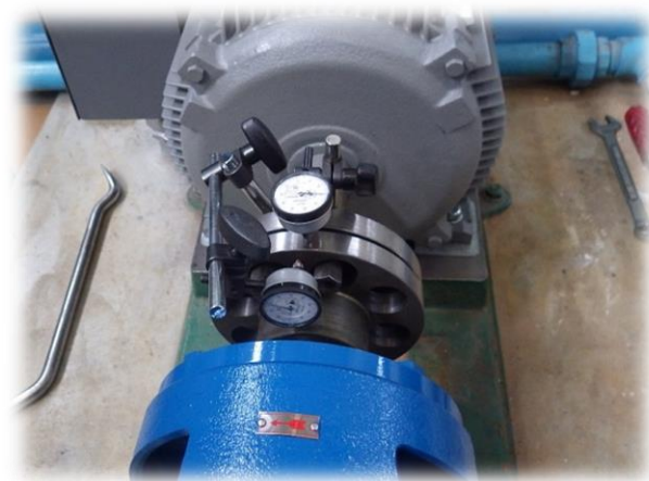
写真-4 機械設備芯出し測定（真空ポンプ～モータ）
