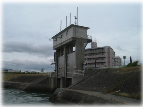
写真-2 榎瀬樋門外観（2代目）
