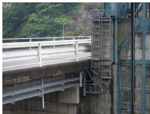
写真-4 各ピア配電線路(施工中)
