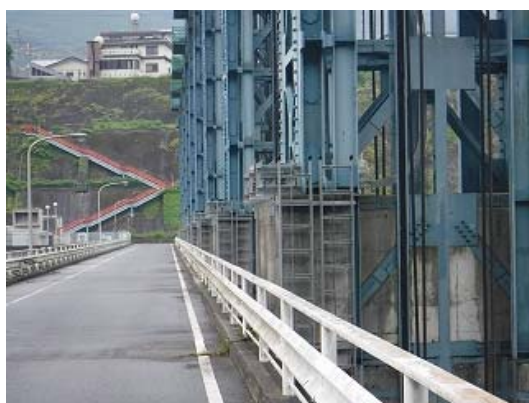
写真-3 各ピア配電線路(施工中)
