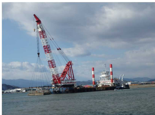
写真-2 ケーソン仮置のためのえい航作業
