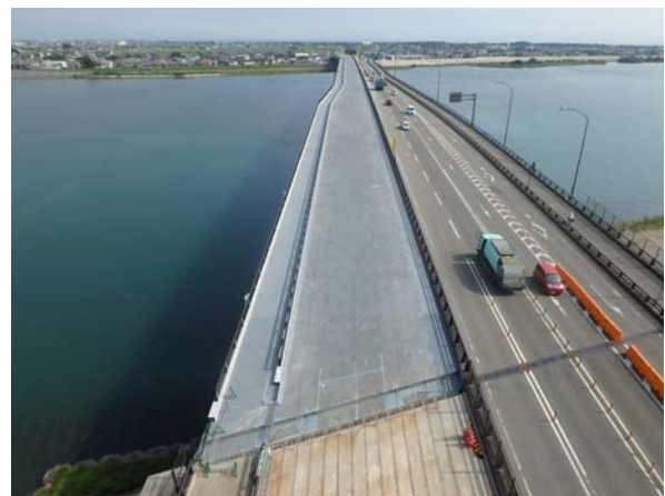
写真-1 那賀川大橋舗装前状況
