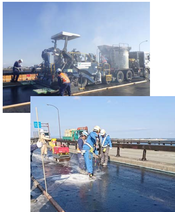
写真-3 フィニッシャー及び敷均し状況
