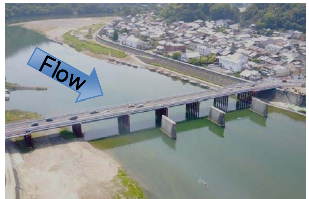
図-1 仮橋と下流に残存している既設橋脚(H29.9)
