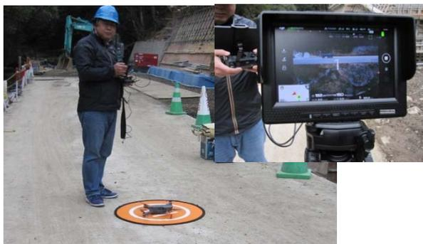
図-4 ドローンと画像確認用モニター
