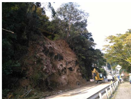
写真-2 不安定岩塊の撤去完了状況
