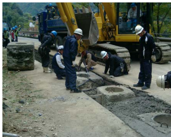
写真-5 基礎杭周辺の施工状況
