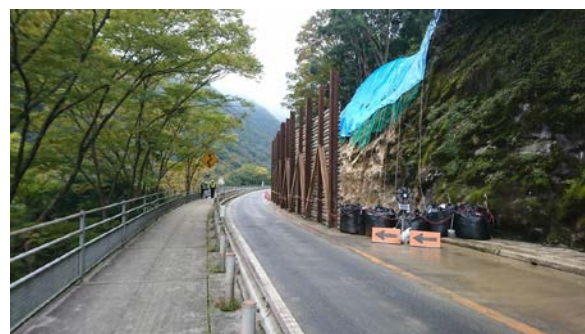
写真-3 不安定岩塊の撤去完了状況
