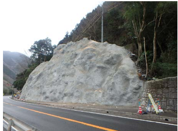
写真-9 規制解除時の状況
