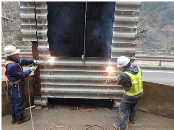
写真-8 仮設防護柵撤去作業図
